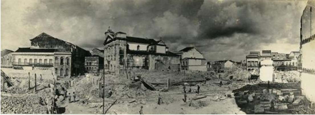
Imagem 12. Demolição da Igreja do Corpo Santo, S/D. 10,8 x 29,8 cm. Acervo do Museu da Cidade do Recife.
