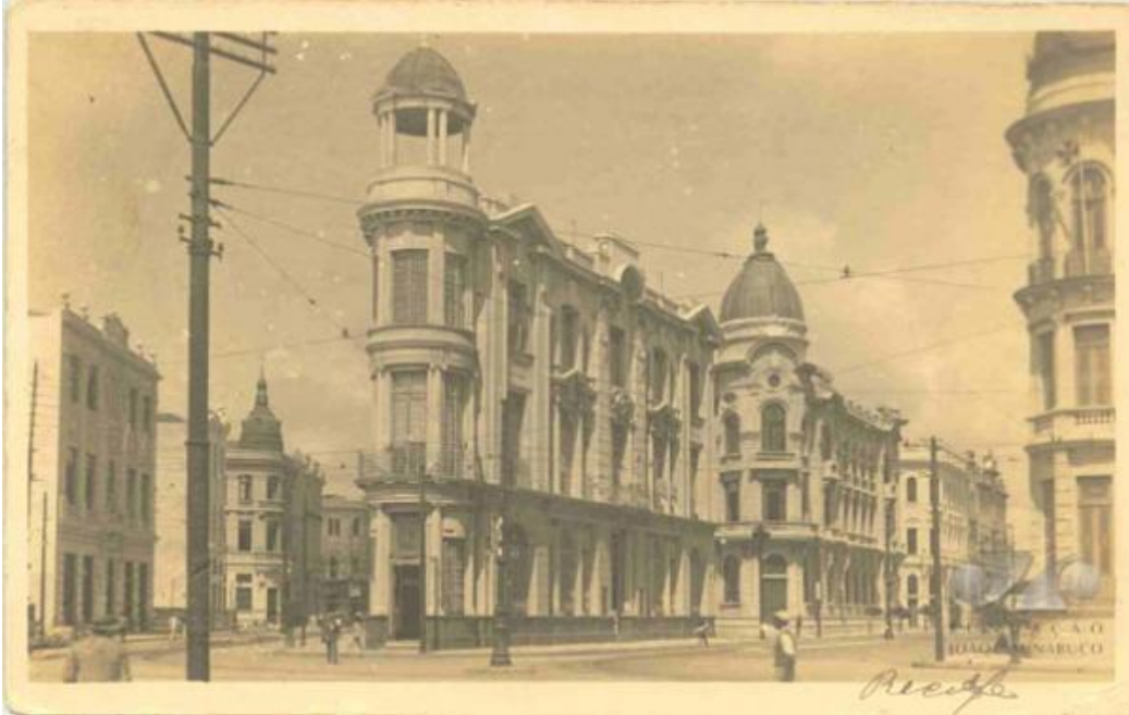
Imagem 56. Edifícios da Avenida Alfredo Lisboa, s/d. Francisco Du Bocage. 8,6 x 13,6 cm. Acervo Fundaj.
