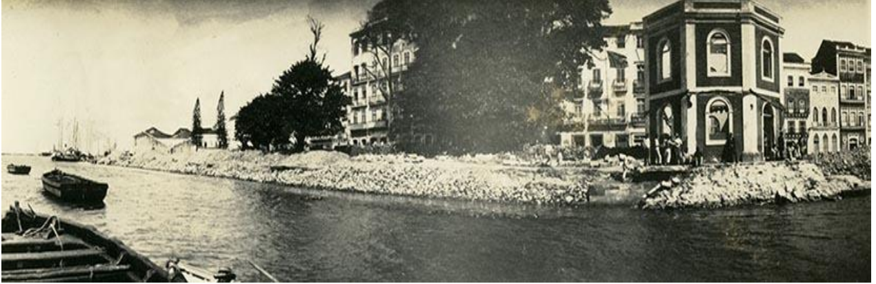
Imagem 45. Demolição do Antigo Cais da Lingueta, s/d. 10,8 x 29,8 cm Acervo Museu da Cidade do Recife.
