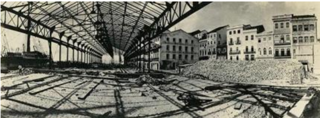
Imagem 13. Construção do Armazém do Porto S/D. 10,8 x 29,7 cm Acervo do Museu da Cidade do Recife.
