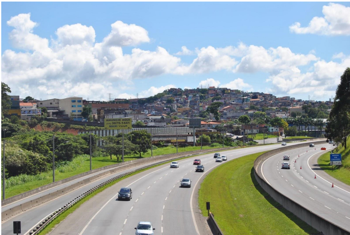
Chegada ao Bairro dos Pimentas pela Rodovia Ayrton Senna.
