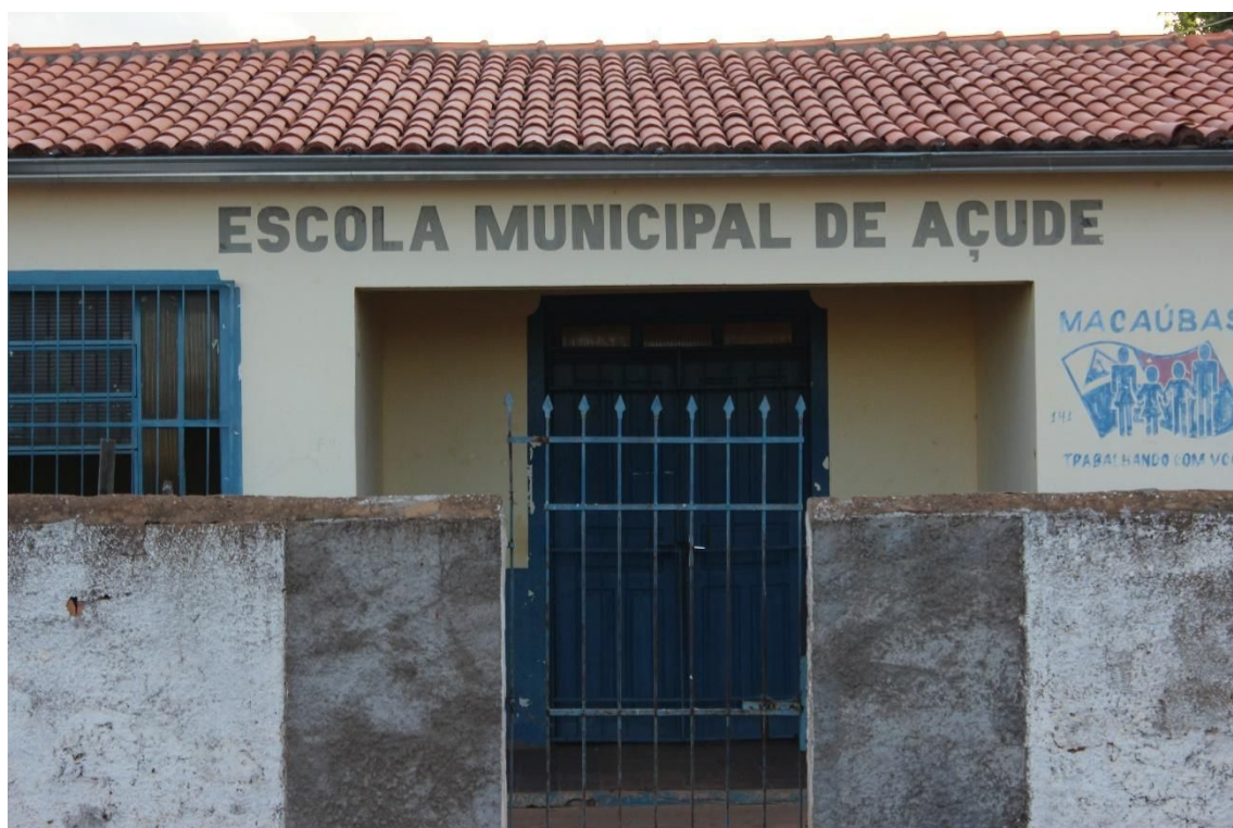
Escola municipal de Açude (2018)
