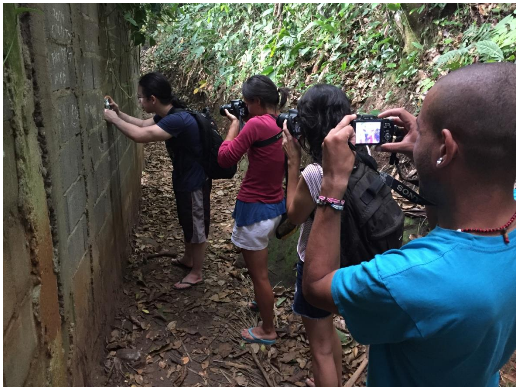
Fotógrafo: Edgar Teodoro da Cunha
