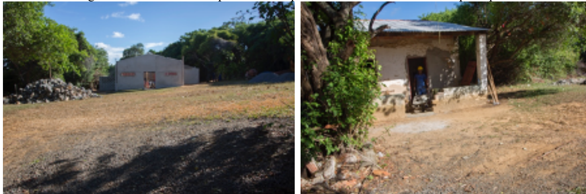
Figuras 51 e 52: Reforma do barracão © Daniele, 2019.
